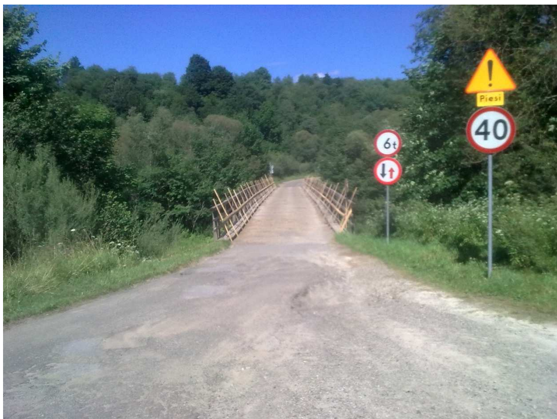
Widok na nawierzchnie mostu oraz zastawy z listewek drewnianych
